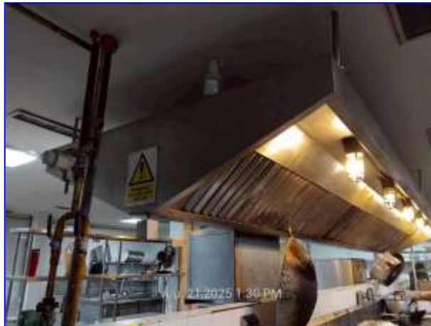
รูปที่ 2.37 ระบบระบายอากาศในห้องครัวและห้องพัก
