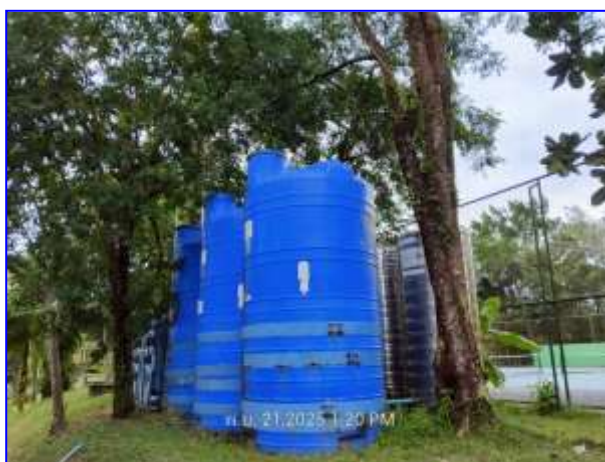
รูปที่ 2.40 ถังกรองน้ำชนิด Multimedia filter
